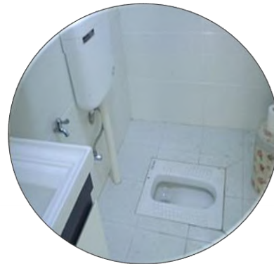
Cistern flush toilet
