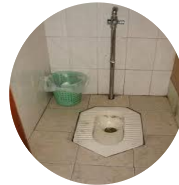
Pour flush toilet
