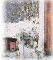
Bucket latrine பக்கட் கழிப்பறை
