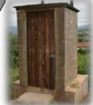
Pit latrine குழி கழிப்பறை
