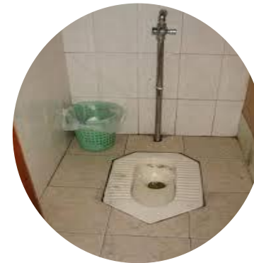
Pour flush toilet
